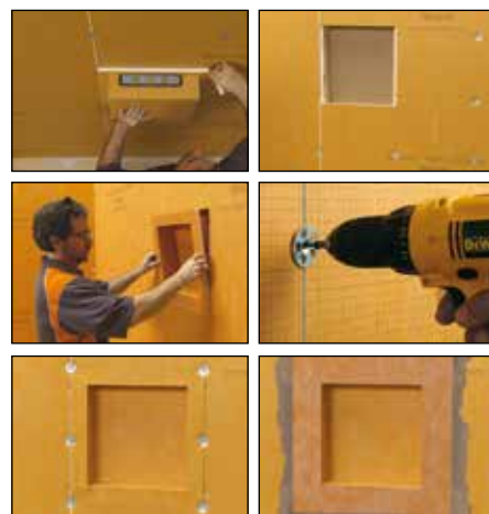
Montáž do KERDI-BOARD
