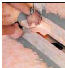
ad 2. KERDI manžeta se přilepí Přiřízne se KERECK vnitřní kout
