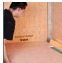
ad 3. Zasunutí spádové desky pod těleso žlabu
