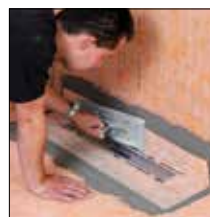
ad 4. Přilepení KERDI manžety pomocí KERDI-COLL-L
