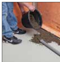
ad 6. Nanesení spádového potěru
