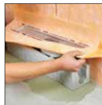
ad 2. Osazení tělesa žlabu
