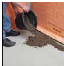
ad 3. Nanesení vyrovnávacího potěru
