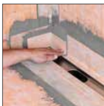
ad 3. Nalepí se KERECK vnitřní kout
