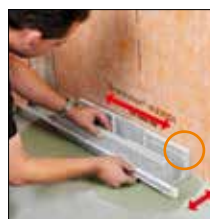
ad 1. Vyrovnání nosného prvku žlabu
