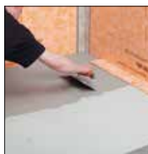
ad 6. Nanesení tenkovrstvého lepidla
