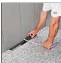
ad 4. Vyměří se dlažba pro nosič pro nalepení dlažby ...
