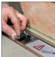
ad 2. Rám se nastaví pomocí pomůcky pro nastavení výšky ...
