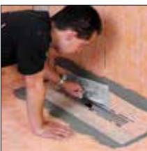
ad 4. Přilepení KERDI-manžety pomocí KERDI-COLL-L
