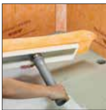
ad 2. Osazení odtokové trubky
