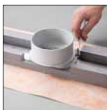
ad 3. Opětovné přišroubování adaptéru
