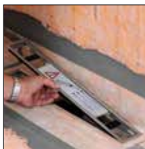
ad 1. Vloží se rám včetně distančního pásku
