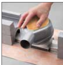
ad 3. Nasazení odtokového tělesa na adaptér
